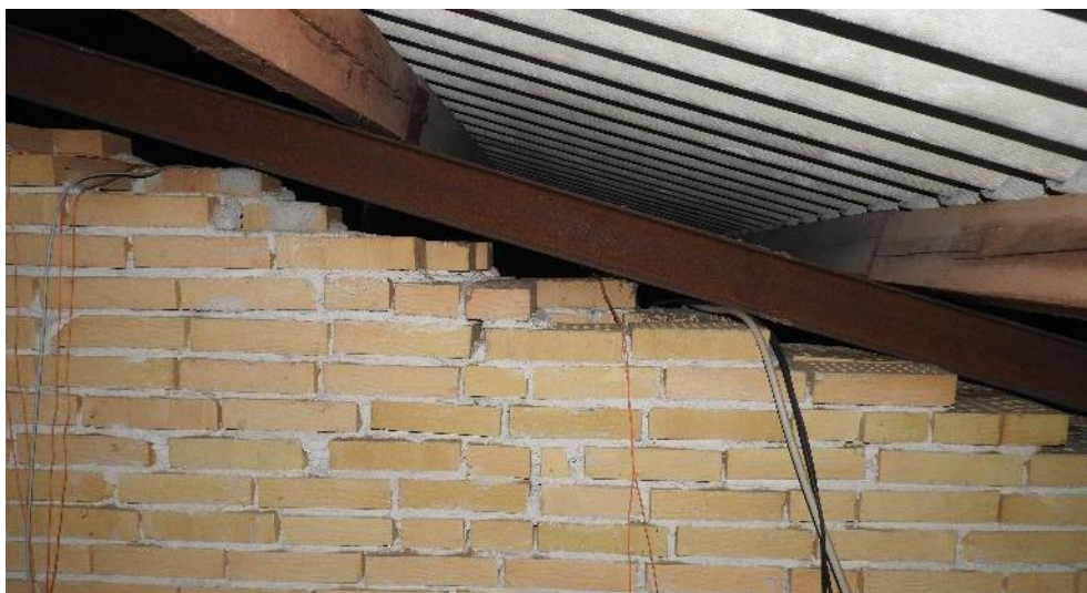
Figur 2-5 Muret væg ind mod loftet til driftsbygningen
