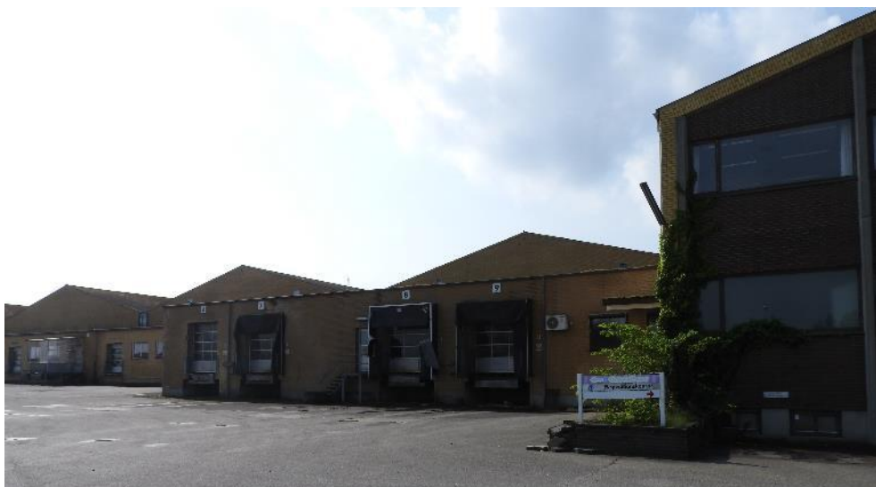
Figur 7-1. Eksisterende bygninger i planområdet.
