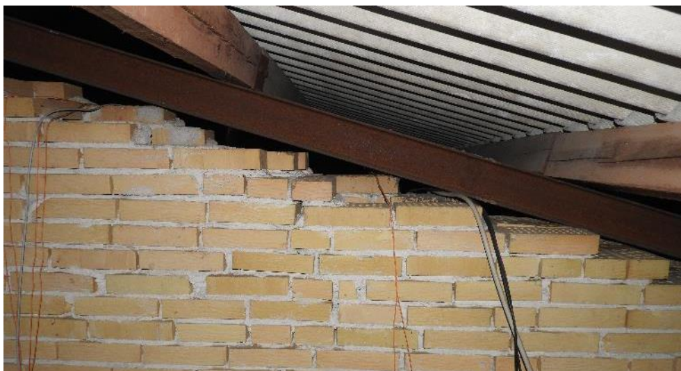
Figur 7-5 Muret væg ind mod loftet til driftsbygningen.
