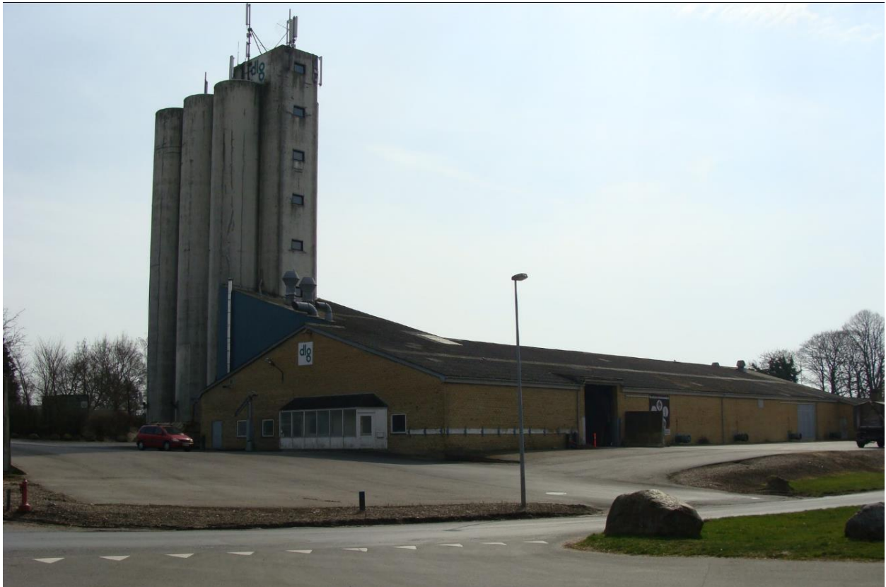
Fig. 15. 32 m høje siloer på Langemosevej 2.
