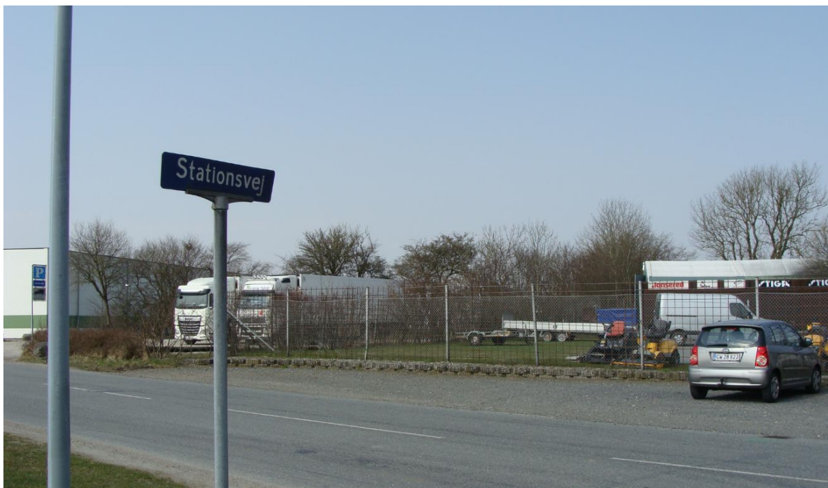
Fig. 4. Kig fra Ringvej/Stationsvej mod det ansøgte højlager. Eksisterende bygninger på Orskov Foods ses til venstre.
